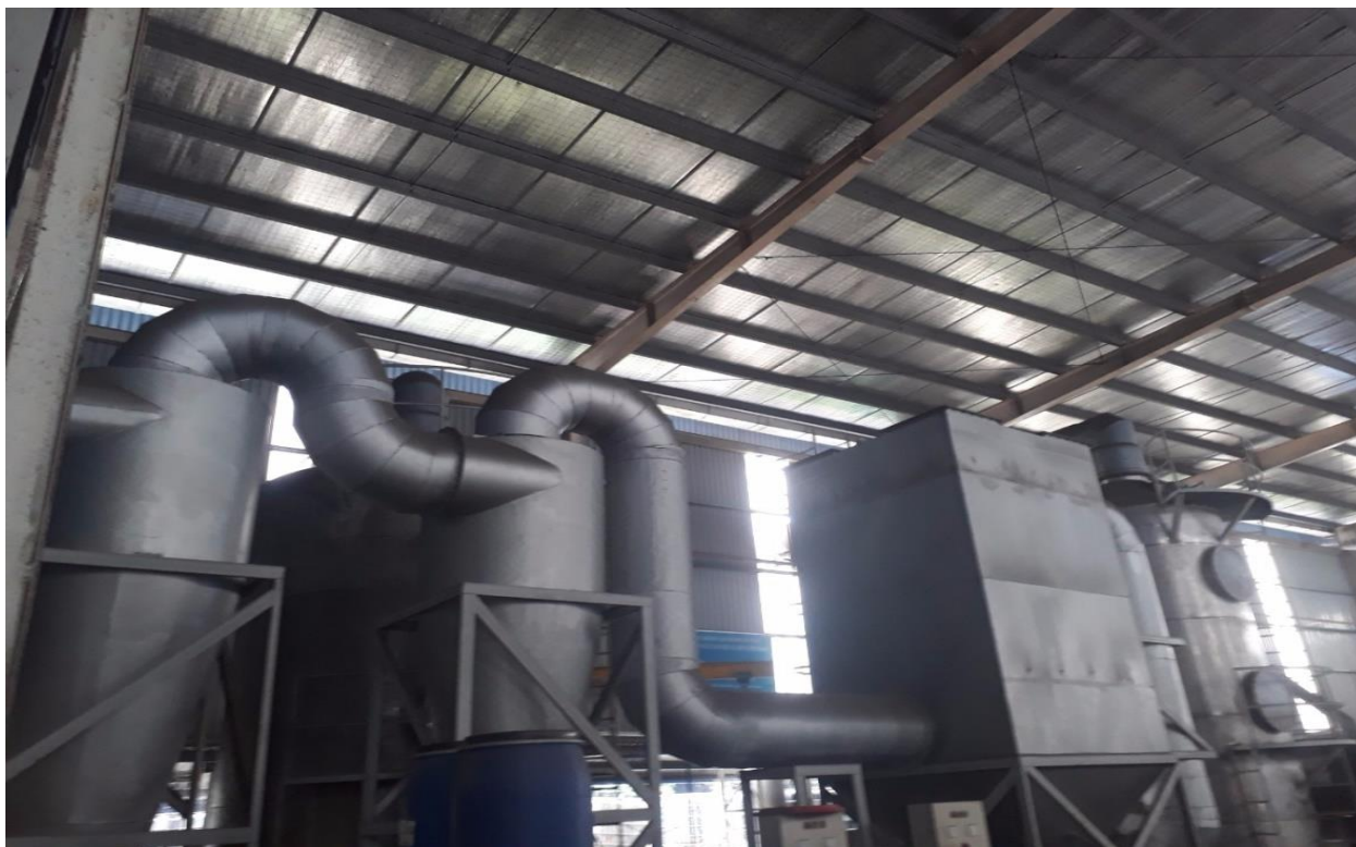
Hệ thống xử lý khí thải phân kim
